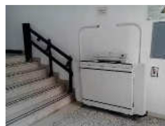
Servo scala ala vecchia tra il piano terra e il piano terra rialzato (biblioteca)
