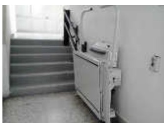
Servo scala ala vecchia tra il piano terra e il piano terra rialzato (palestra Nord)
